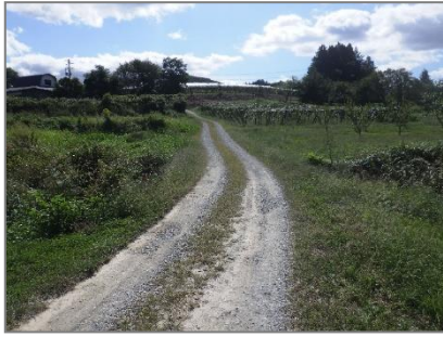
・ 3037 岡田橋 起点側
