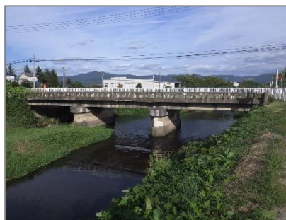
五内川橋 側面
