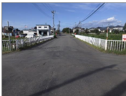
・ 3138 五内川橋 起点側
